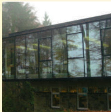
BÜROZUBAU FA. MANDLBAUER BAUHERR Bauunternehmung Ing. Mandlbauer, Bad Gleichenberg PLANUNG Arch. Bramberger, Graz AUSFÜHRUNG Kulmer Holz-Leimbau GmbH, Pischelsdorf
