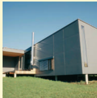
HANG IM HAUS BAUHERR Karin und Mag. Christian Jöbstl, Bad Gleichenberg PLANUNG polar+, Bad Gleichenberg AUSFÜHRUNG STEYER Holzbau GmbH, Ilz
