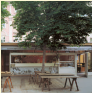
MARKTSTAND SCHNABELWEIDE BAUHERR: Gisela u. Andeas Zöpnek, Graz PLANUNG Innocad GmbH und Clemens Luser, Graz AUSFÜHRUNG Holzbau Hirschböck, Hartberg
