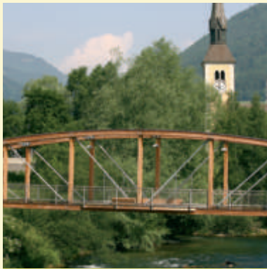
FUSSBRÜCKE ÜBER DIE MÜRZ BAUHERR Stadtgemeinde Kapfenberg, Kapfenberg PLANUNG formart ST – Arch. DI Sandra Taendler, Kapfenberg AUSFÜHRUNG Fa. Kulmer, Pischelsdorf
