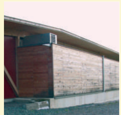
HOLZWERK GOLLOB BAUHERR Johann Gollob, Großklein PLANUNG Josef Konrad Zimmerei, Frohnleiten AUSFÜHRUNG Josef Konrad Zimmerei, Frohnleiten
