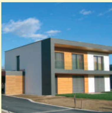
HAUS JELINEK BAUHERR Jelinek Kurt und Silvia, Pöllau PLANUNG Zeichenbüro Schwarhofer, Mönichwald AUSFÜHRUNG Holz Bau Weiz, St. Ruprecht
