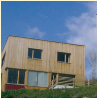
4 EFH KALKÖFEN BAUHERR Fam.Sauer, Münch, Leitner, Trummer, Stattegg PLANUNG Schwarz Platzer ARCHITEKTEN.zt-gmgH, Graz AUSFÜHRUNG Zimmerei Peter Nistelberger, Krottendorf/Weiz
