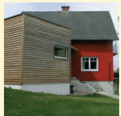
ATELIERZUBAU SCHWARZINGER BAUHERR Johann Schwarzinger, Weintzen PLANUNG Zimmerei Werner Pieber GmbH, Bad Blumau AUSFÜHRUNG Zimmerei Werner Pieber GmbH, Bad Blumau
