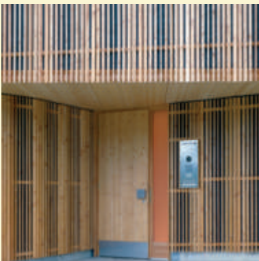
LÄRMSCHUTZWAND + SOMMERKÜCHE WALLNER BAUHERR Wallner Christian, Scheifling PLANUNG SPS – Architekten, Thalgau AUSFÜHRUNG Erwin u. Ing. Robert Wagner GesmbH & CoKG, Scheifling
