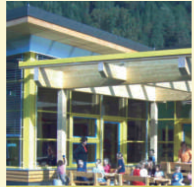
KINDERGARTEN STADL AN DER MUR BAUHERR Gemeinde Stabl an der Mur, Stabl an der Mur PLANUNG Architekt Dipl.-Ing. Peter Kapfenberger, Zeltweg AUSFÜHRUNG Ehrenreich BaugesmbH, Tamsweg
