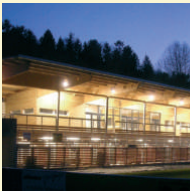
SC ST MARGARETHEN SPORTHÄUSNEUBAU BAUHERR Orts- u. Infrastrukturentwicklungs- KEG, St. Margarethen /R. PLANUNG Arch. DI. Christian Meier, Graz AUSFÜHRUNG Kulmer Holz-Leimbau GmbH/Zimmerei Stefanec, Pischelsdorf/Studenzen
