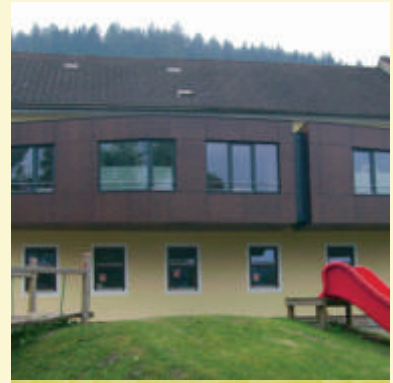
TAGESFÖRDERSTÄTTE PIUS INST. DER KREUZSCHWESTERN BAUHERR Pius Institut der Kreuzschwestern, Bruck an der Mur PLANUNG S-M-XL Architekten, Graz AUSFÜHRUNG Josef Dengg KG nunmehr GmbH & Co KG, Graz
