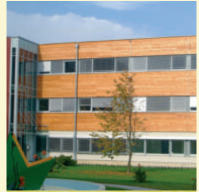
ZUBAU BÜROGEBÄUDE PDC GRAMBACH BAUHERR PDC Verfahrenstechnische Entwicklungs GmbH, Grambach PLANUNG Zengerer & Jungwirth Planung GmbH, Graz AUSFÜHRUNG Holz Bau Weiz, St. Ruprecht/Raab
