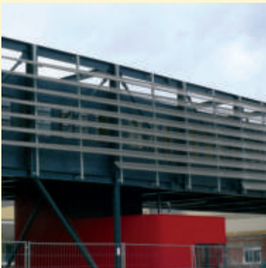
EMPFANGSGEBÄUDE AUSTRIA EMAIL KNITTLEFELD BAUHERR Austria Email AG, Knittelfeld PLANUNG Hofrichter-Ritter Architekten, Graz AUSFÜHRUNG Holzbau Themessl, Einöde/Villach
