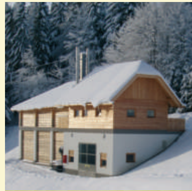
HEIZWERK BRANDLUCKEN BAUHERR Biomasse Nahwärme reg.Gen.m.b.H., St. Kathrein am Offenegg PLANUNG Ing. Leo Riebenbauer, Pinggau AUSFÜHRUNG Holzbau Winkler, Pinggau
