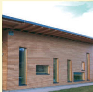
PRIVATKINDERGARTEN KOCHER BAUHERR Privatkindergarten Kocher GmbH, Graz PLANUNG Arch.DI.Michael Kocher, Graz AUSFÜHRUNG: Bau und Holz Posch, Eibiswald
