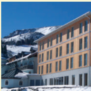
HOTEL KORNOCK BAUHERR Hotel Kornock GmbH, Turracherhöhe PLANUNG Planungsbüro BM Hiesleitner, Graz AUSFÜHRUNG Ehrenreich Ing. L. E. Krist BauGmbH, Tamsweg
