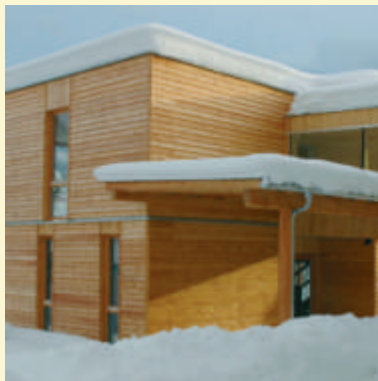
ZUBAU VERWALTUNGSZENTRUM WENG BAUHERR Nationalpark GmbH, Weng i. Gesäuse PLANUNG Jutta Wörthl Gössler, Wien AUSFÜHRUNG Holzbau Strobl, Preding/Weiz
