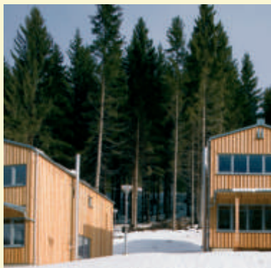
HÜTTENDORF PRÄBICHL GMBH BAUHERR Hüttendorf Präbichl GmbH, Graz PLANUNG Rudolf & Vier Partner GmbH, Graz – Projektpartnerschaft DI Jacqueline Walcher, Graz AUSFÜHRUNG Steyer Holzbau GmbH, Ilz
