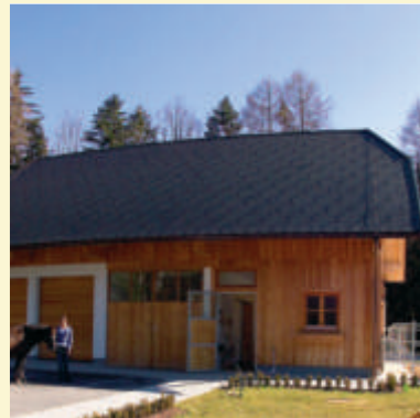
NEUBAU HOFSTELLE BAUHERR Egger Ernst und Andrea, Aigen im Ennstal PLANUNG Bmst. Ing. Kniewasser Siegfried, Windischgarsten AUSFÜHRUNG Mehrl GmbH, Aigen im Ennstal
