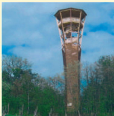
WEINWARTE ST. PETER A. OTTERSBACH BAUHERR Marktgemeinde St. Peter am Ottersbach, St. Peter am Ottersbach PLANUNG Wörle Sparowitz Ingenieure, ZT GmbH, Graz AUSFÜHRUNG Kulmer Holz-Leimbau GesmbH, Pischelsdorf
