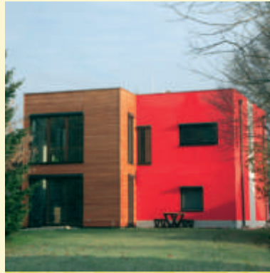
WOHNHAUS JEITLER BAUHERR Jeitler Christian, Sinabelkirchen PLANUNG Wolfgang Schille, Frohnleiten AUSFÜHRUNG Zimmermeisterbetrieb Manfred Zarnhofer, Frohnleiten
