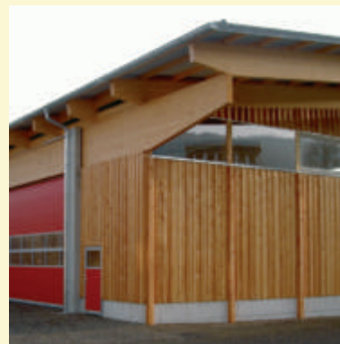
HOBELHALLE SÄGEWERK BICHLER BAUHERR Sägewerk Hans Bichler, Knittelfeld-Kobenz PLANUNG Alpe Ges.m.b.H. Zimmerei, Fohnsdorf AUSFÜHRUNG Alpe Ges.m.b.H. Zimmerei, Fohnsdorf
