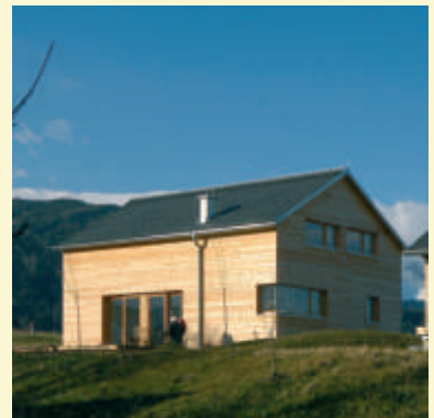
EFH WINTERLEITNER BAUHERR DI Petra Winterleitner, Trofaiach PLANUNG DI Petra Winterleitner, Trofaiach AUSFÜHRUNG J.STROBL Holzbau GmbH, Weiz
