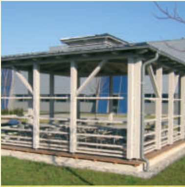
PAVILLON FIRMA ANTON PAAR IN BEWEGUNG BAUHERR Fa. Anton Paar GmbH, Graz PLANUNG Josef Dengg KG nunmehr GmbH & Co KG, Graz AUSFÜHRUNG Josef Dengg KG nunmehr GmbH & Co KG, Graz
