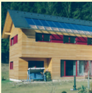
PASSIVHAUS KONRAD BAUHERR Josef Konrad, Frohnleiten PLANUNG Dipl.-Ing. Erwin Kaltenegger, Passail AUSFÜHRUNG Josef Konrad Zimmerei, Frohnleiten
