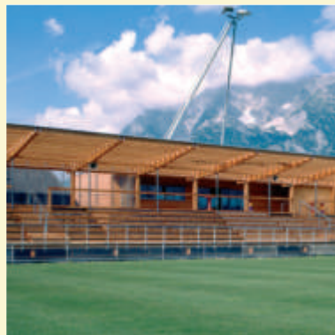
FUSSBALLUMKLEIDE UND TRIBÜNE, IRDNING BAUHERR Orts- u. Infrastrukturentw. KEG, Irdning PLANUNG Architekt DI Gerhard Mitterberger ZTgmbH, Graz AUSFÜHRUNG J. Strobl GmbH, Weiz
