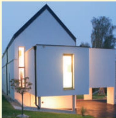
WOHNHAUS ZOTTER BAUHERR Zotter Helmut, Kainbach b. Graz PLANUNG Wolfgang Schille, Pischelsdorf – Frohnleiten AUSFÜHRUNG Zarnhofer Zimmermeisterbetrieb, Frohnleiten
