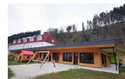
Erweiterung Kindergarten Waldbach
