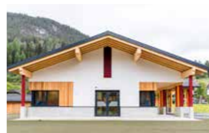
Neubau Wohnhaus u. Tagesstätte Lebenshilfe Oberwölz
