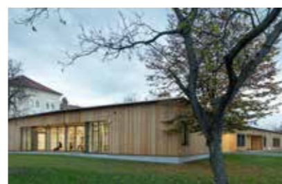
Station in Holzbauweise, LKH Graz II, Standort Süd
