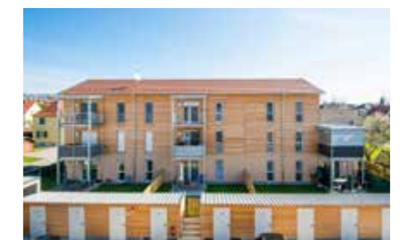
Mehrfamilienhaus Dittlergasse, Weiz
