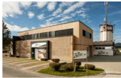
Neubau Betriebsgebäude M. Zottler Tischlerei GmbH
